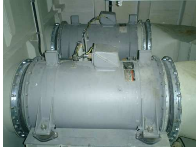
Fig. 3.1 Axial type high pressure fan
