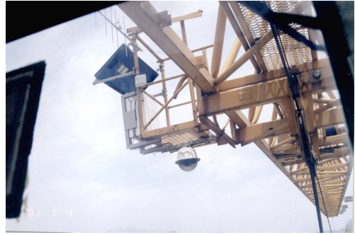
b) 크레인에 설치된 컴포넌트
