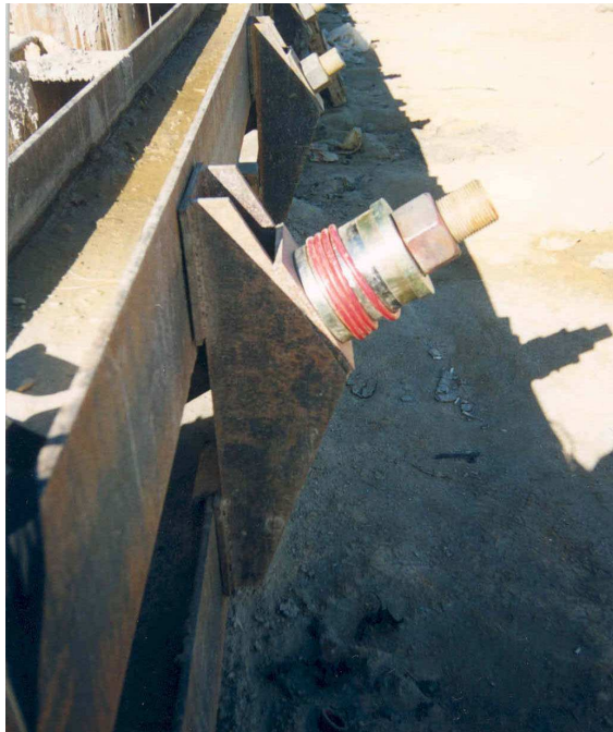
그림 3.9 하중계 설치완료후 모습
