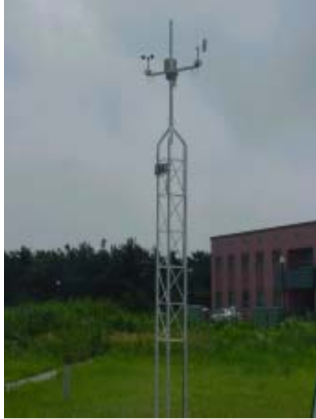
그림 4.23 기상요소 측정 전용 기상 Tower
