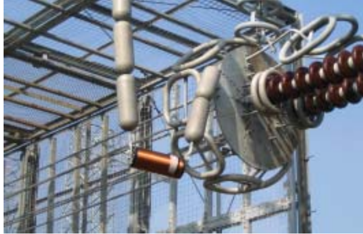
그림 4.25 전원측 불요잡음 차단용 Blocking Coil
