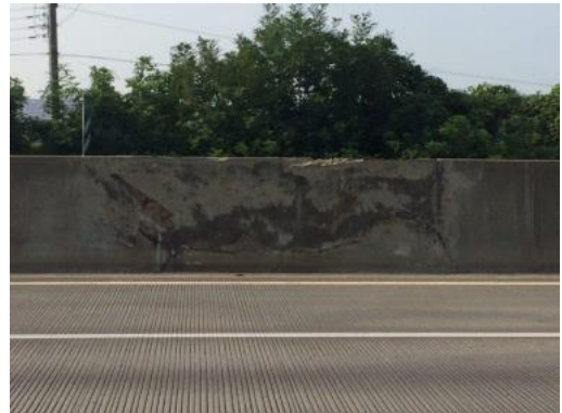
Fig. 1-3 차량충돌에 의한 중앙분리대 파손 사례(평택제천고속도로)
