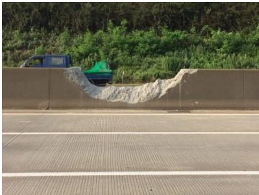
Fig. 1-3 차량충돌에 의한 중앙분리대 파손 사례(평택제천고속도로)
