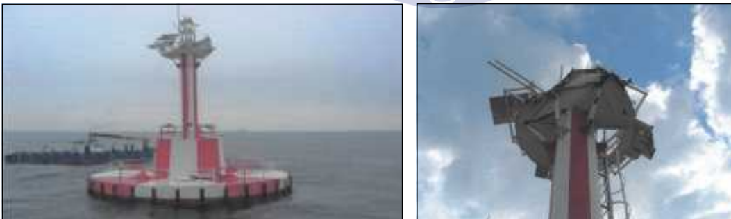
Fig. 12 부산항유도등부표 손상 모습
