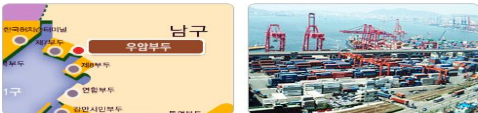
[그림 3-3] 우암부두 위치 및 전경
