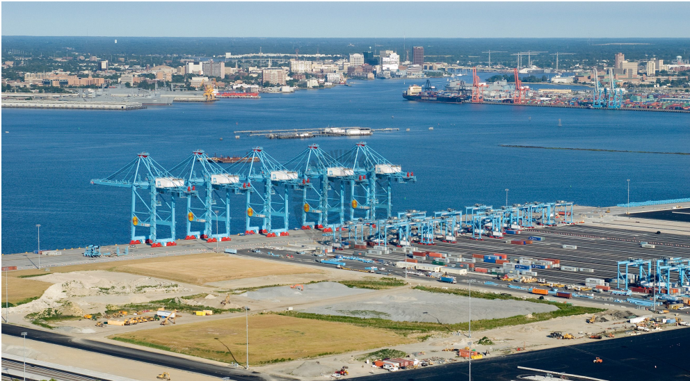
<그림 4-6> APM Terminals Virginia 전경
